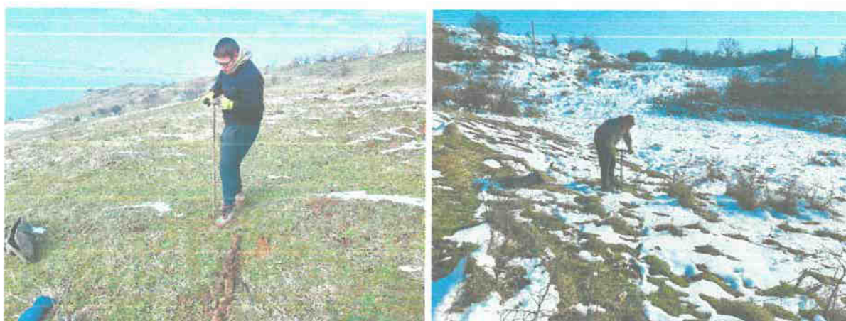
Fig.8. Execuția forajului F1 (stânga) și execuția forajului F3 (dreapta)
